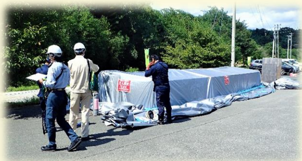
（シートで被覆して24時間燻蒸処理）
