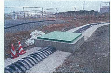
写真① 暗渠化施工完了(ダブルプレスト管)
