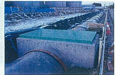
写真② 暗渠化施工完了(FRP管)
