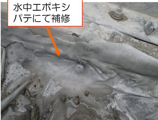
【H5 西側の漏洩箇所の補修状況】
