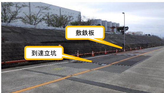
(写真 4) 上流側の既設到達立坑付近の状況
