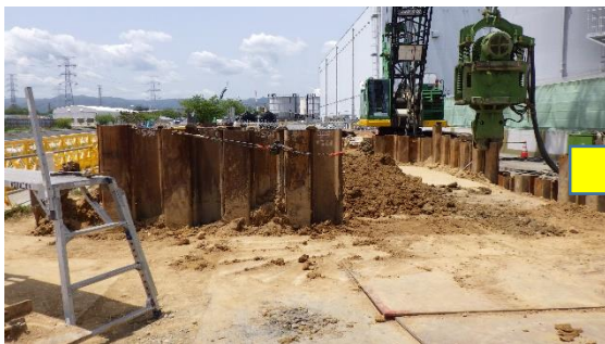
(写真2-1) 両発進立坑の状況 (令和3年5月14日撮影)
