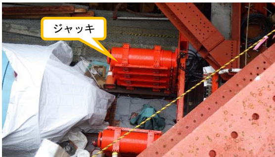
(写真 2 - 4) 両発進立坑底部の状況②
