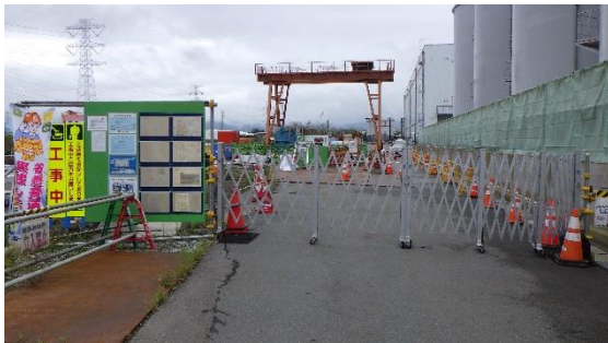
(写真1) 両発進立坑の工事現場の状況 (東側から撮影)
