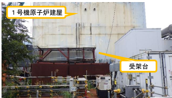
(写真1-2) アンカー削孔装置の受架台設置状況 (西側から撮影)
