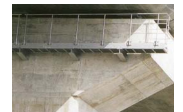
図5 支承周りへの検査路増設
