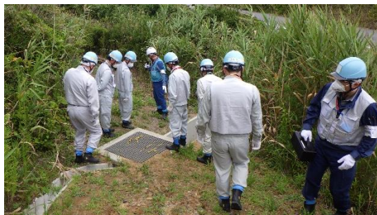
(写真1-5) 南側排水溝排水口付近の状況について (図1②付近)
