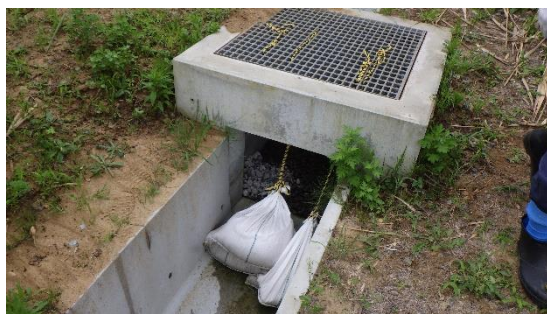
(写真1-6) 一時保管エリア P の南側排水路の陳場沢川合流前に設置されたゼオライト土嚢
