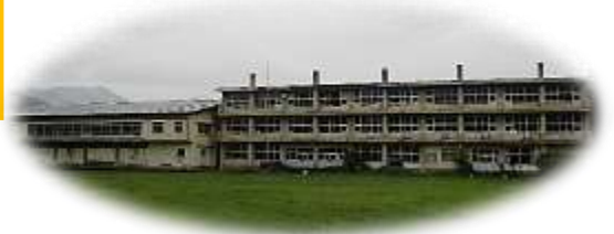
【懐かしい旧伊南小学校校舎】
