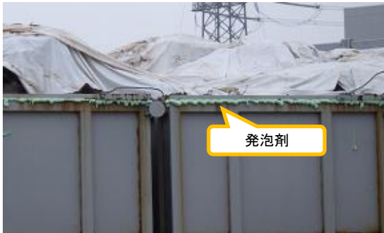
(写真 3) コンテナ蓋隙間の閉止状況
