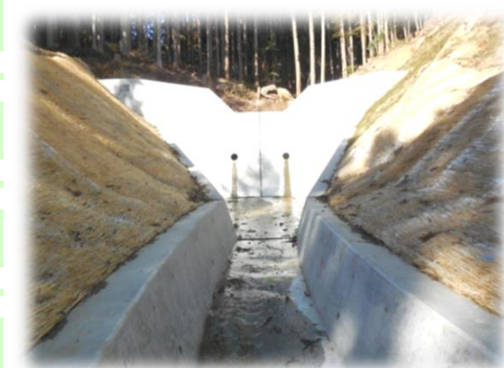
見学した治山施設
