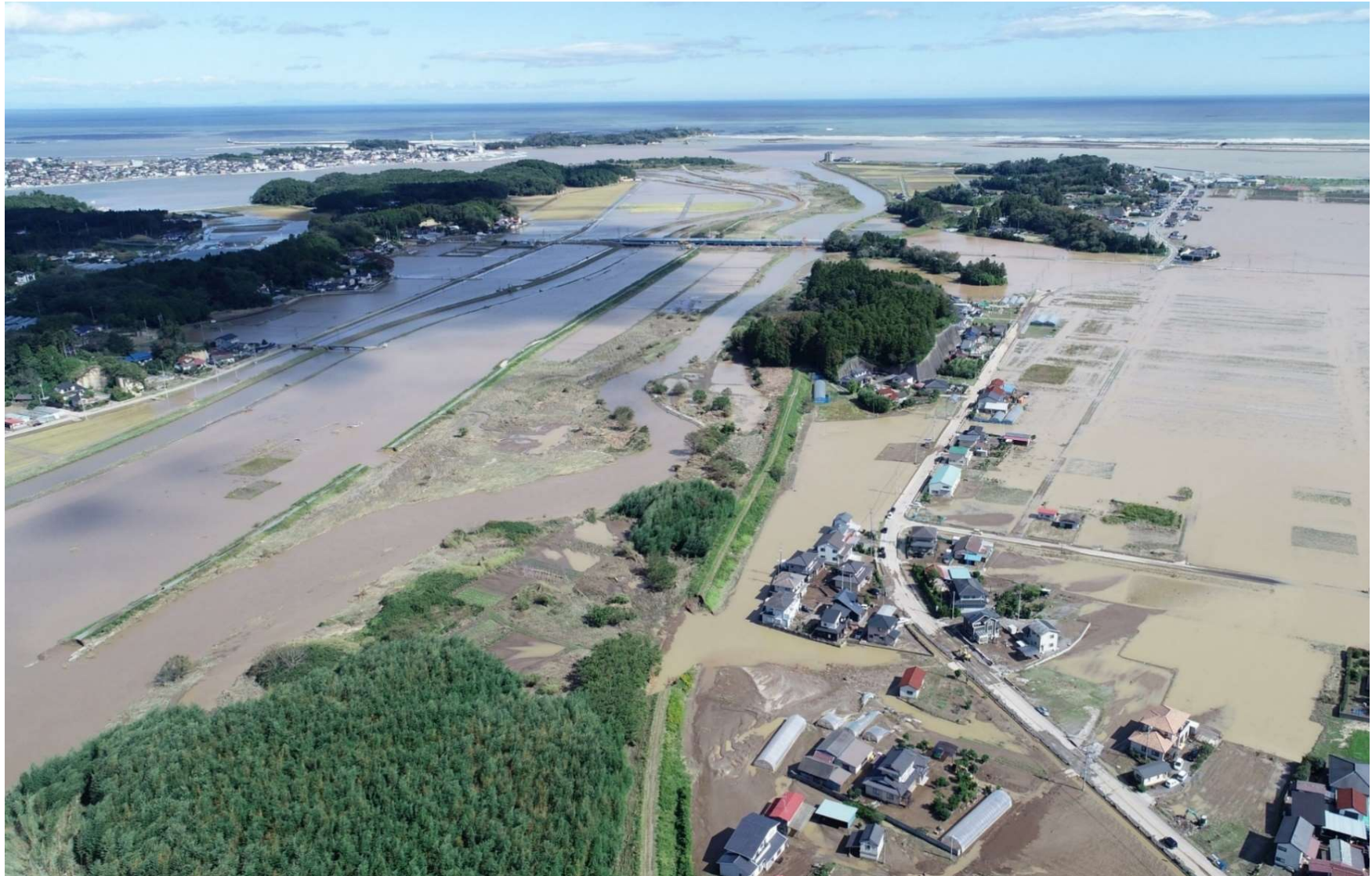
令和元年度台風19号被災状況(宇多川・小泉川・国道6号下流)
