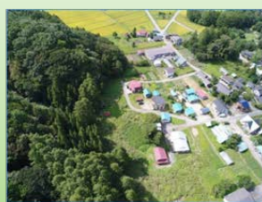
土砂流出防備保安林（南会津町）
