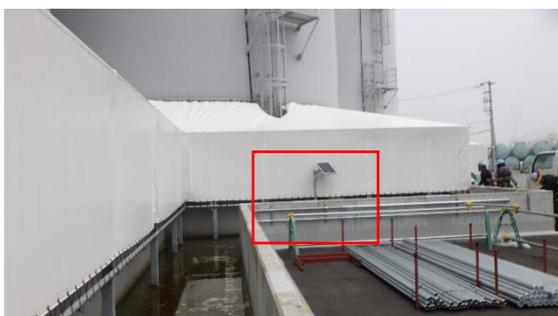
(写真3-1) H4北タンクエリア東側地震計の設置状況
