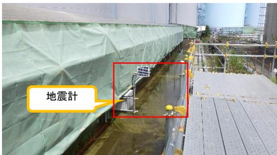
(写真1-1) Dタンクエリア北東側地震計の設置状況
