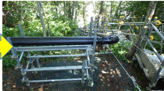
(写真 1 - 6) 配管敷設状況③ (今回(8月4日)) (5・6号機南側法面法肩を南側から撮影)
