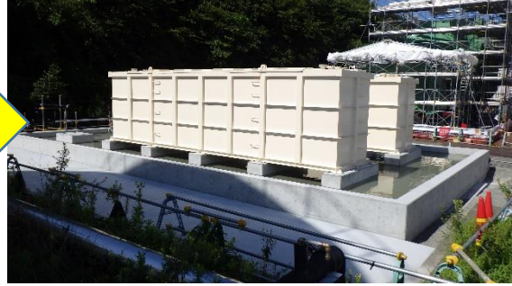
(写真 2 - 2) 中継タンク設置状況（今回(8月4 日)）（北東側から撮影）
