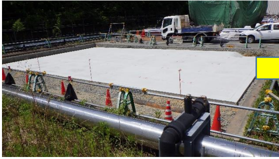
(写真 2 - 1) 中継タンク設置予定地の状況（前回 （5月12日））（北東側から撮影）
