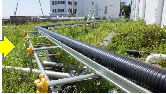
(写真 1 - 2) 配管敷設状況① (今回(8月4日)) (6号機タービン建屋東側を北側から撮影)
