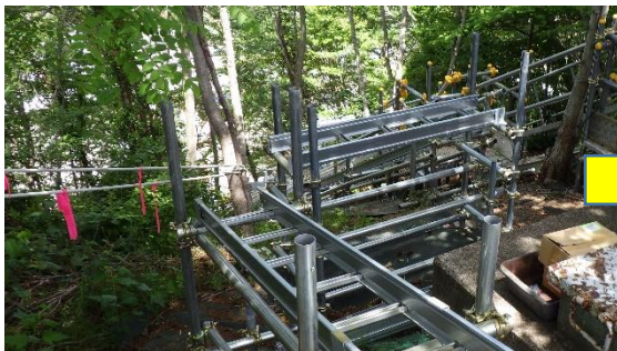
(写真 1 - 5) 配管敷設状況③ (前回(5月12日)) (5・6号機南側法面法肩を南側から撮影)
