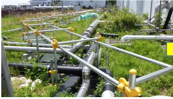
(写真 1 - 1) 配管敷設状況① (前回(5月12日)) (6号機タービン建屋東側を北側から撮影)
