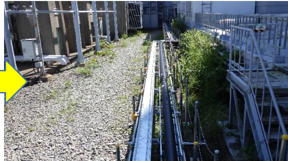
(写真 1 - 4) 配管敷設状況② (今回(8月4日)) (6号機原子炉建屋北東側を西側から撮影)
