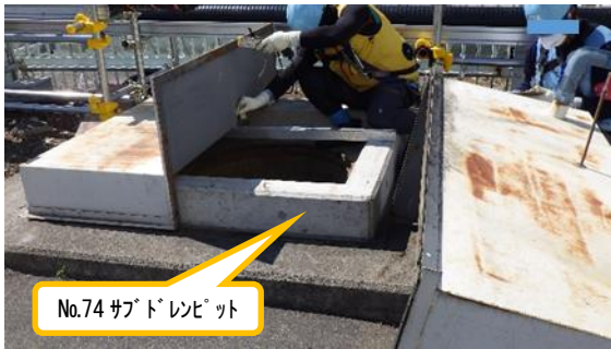
(写真 3) 復旧対象サブドレンピットの事前調 査の状況（北側から撮影）
