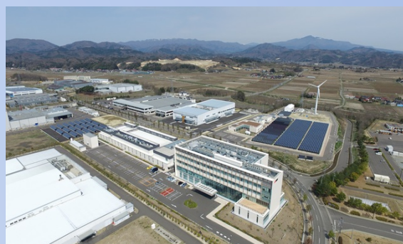
産業技術総合研究所 福島再生可能エネルギー研究所 (郡山市)
