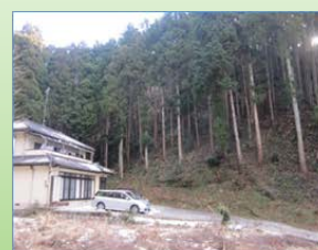
土砂崩壊防備保安林（いわき市）
