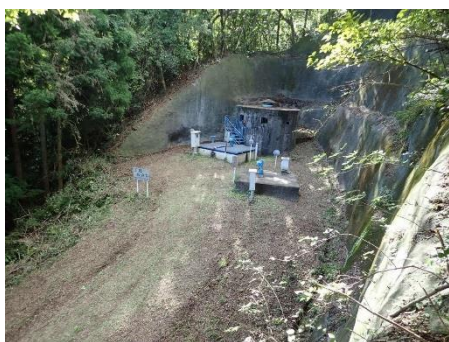
（江畑接合井耐震化工事 施工前）
