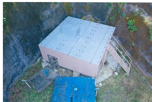
（江畑接合井耐震化工事 施工後）
