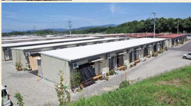
(下)飯舘村から避難した115世帯が暮らす福島市松川工業団地第1仮設住宅。入居者の平均年齢は70歳を超え48世帯が一人暮らしです。
