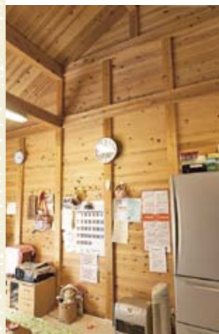
(左)厚さ3cmのスギ板で作った仮設住宅は、土台を強化すれば復興住宅にも利用可能です。
