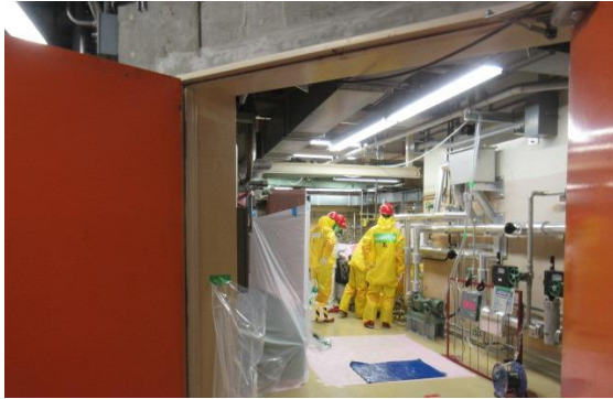
(写真1-1) CRD補修室内での作業状況①
