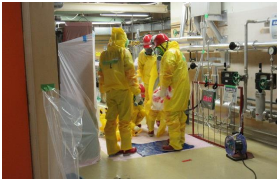
(写真1-2) CRD補修室内での作業状況②
