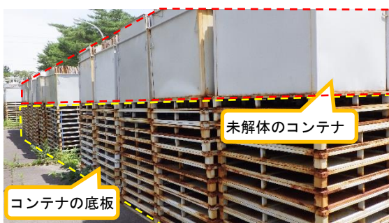
(写真2-1) 一時保管エリア d の状況①
