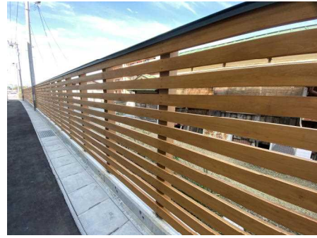
木塀の設置（矢吹町）
