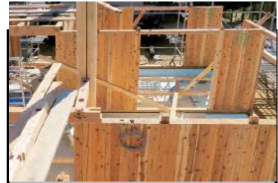
パネルログの施工現場
