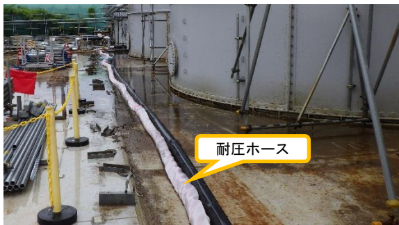
(写真3) 堰内に敷設されている耐圧ホース の状況
