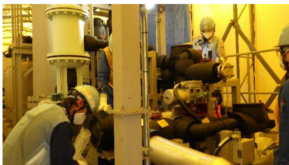
(写真2) 復旧作業中の浄化ユニットDの状況 (現場確認時、圧力計の取替作業が 実施されていた。)
