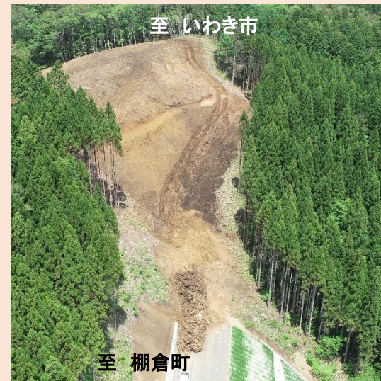
2工区 切土施工状況
