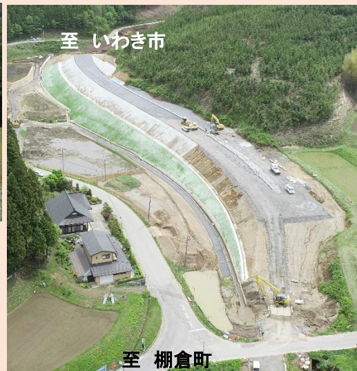
2工区 盛土施工状況
