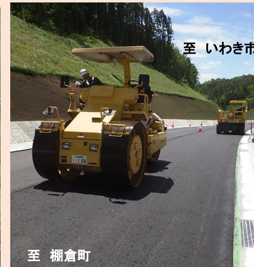
3工区 施工状況
