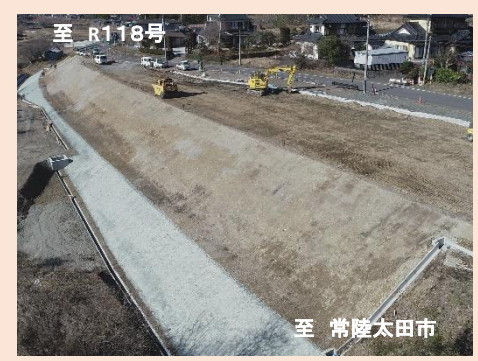
3工区 施工状況
