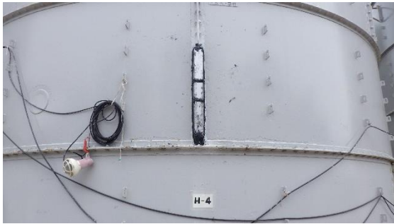
(写真 2 - 2) フランジ接合部の止水剤による補修 状況 (写真 2 - 1 の拡大)
