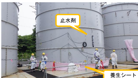
(写真2-1) 養生シート取り外し作業の状況
