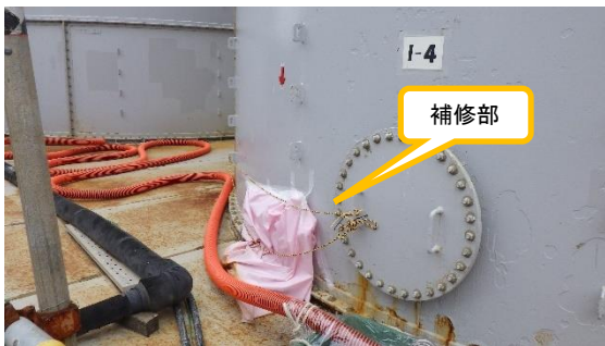
(写真 2 - 3) 補修が完了した箇所の養生の状況
