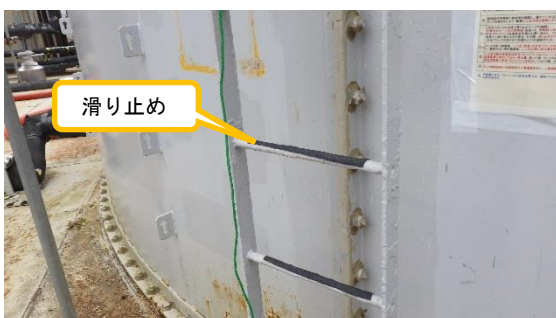
(写真 3 - 2) トラップの滑り止め措置
