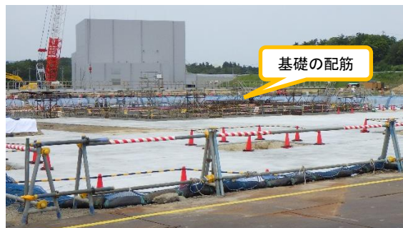
(写真 5 - 2) 今回確認時の工事状況 (令和 3 年 6 月 7 日撮影)
