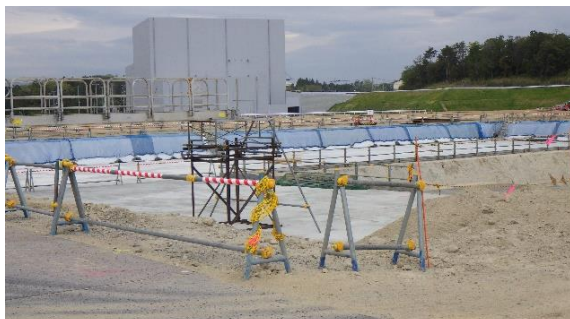
(写真 5 - 1) 前回確認時の工事状況 (令和 3 年 4 月 28 日撮影)
