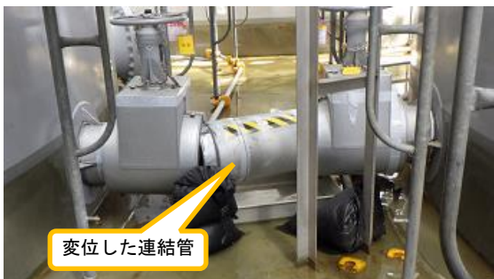
(写真2-1) 連結管取り外し前の状況 (令和3年3月5日撮影)
