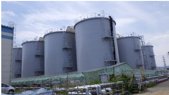
(写真1) Dタンクエリア外観 (北東側から撮影)
