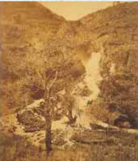
明治15年(1882)、沼上隧道が通水。それは、奥羽山脈をトンネルで貫き、猪苗代湖の水が初めて安積原野に導かれた瞬間でした
