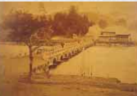
会津の日橋川入り口にある十六橋水門は、安積疏水の開削に伴い、会津側に流れる猪苗代湖の水量を調節するためにつくられました
