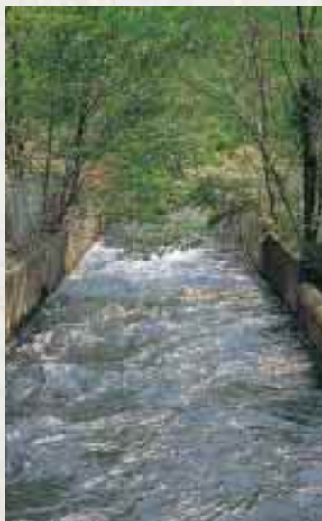
安積疏水の分水路（郡山市熱海町）。疏水により農工業用水から生活用水まで確保された郡山地方は、その後大きく発展しました
