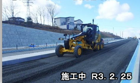
②舗装工事でICT技術を導入
