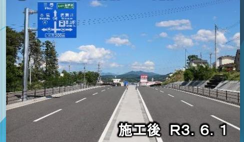
③R3. 6月に標識工が完成
