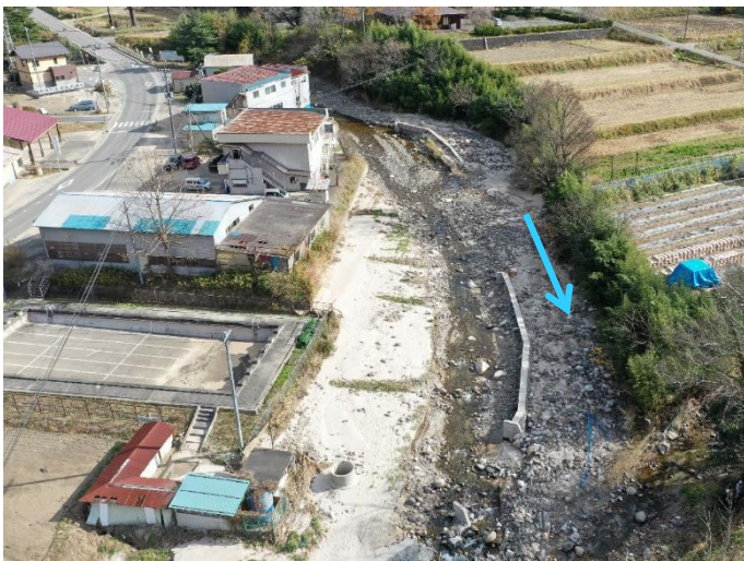
山舟生川（伊達市梁川町山舟生） 被災状況
