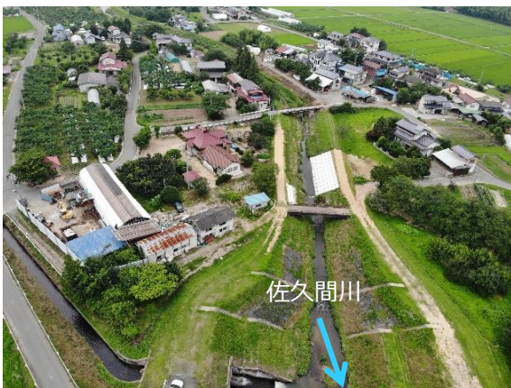
佐久間川（伊達郡桑折町） 応急復旧状況
