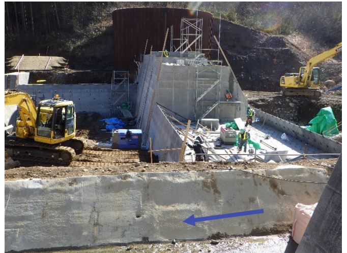
砂防えん堤施工中（東八川筋） [福島市水原]
