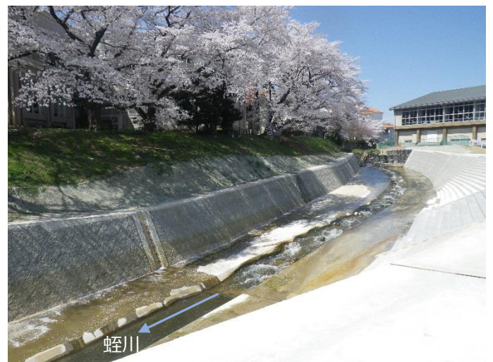
蛭川（福島市瀬上町） 開削護岸
