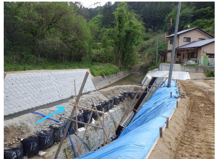
安達太田川（二本松市太田） 護岸整備状況
