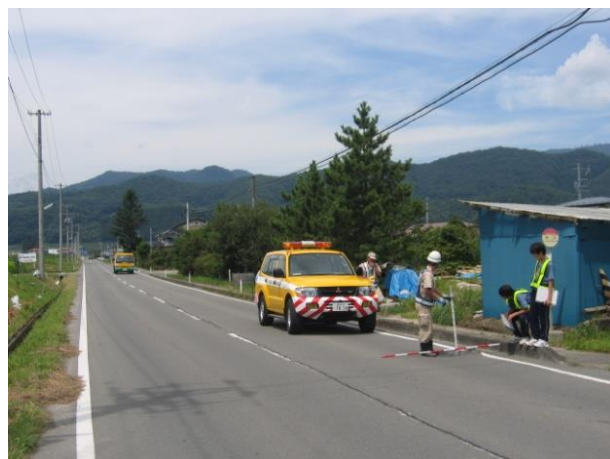
道路の異常を点検している様子
