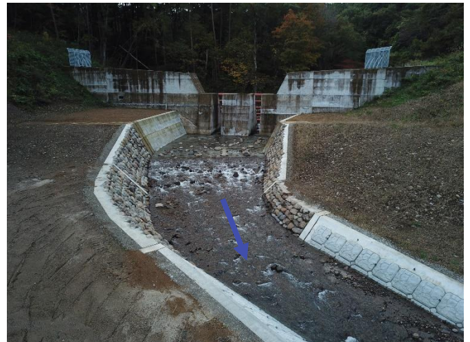
H31砂防えん堤完了（藤入川筋） [福島市水原]
