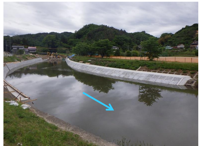
広瀬川（川俣町小島）護岸整備状況
