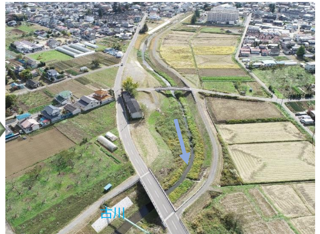
古川（伊達市保原町） 整備完了箇所
