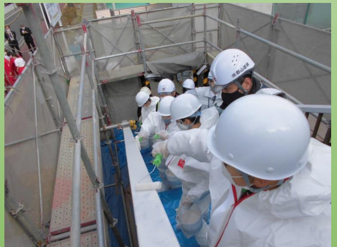
【「安らぎ」と「ゆとり」が持てる県民生活の確保】 杉妻歩道橋 塗装工事 福島第一小学生参加
