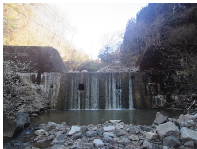
山舟生川砂防えん堤（梁川町）
