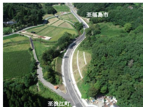
国道114号 山木屋3工区 (川俣町)
