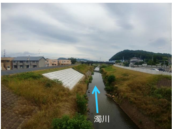
濁川（福島市郷野目） 堤防整備状況
