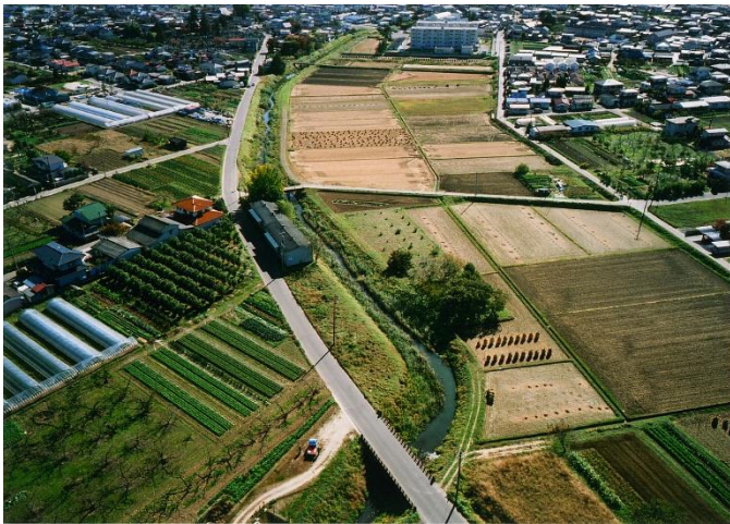
古川（伊達市保原町） 改修前状況
