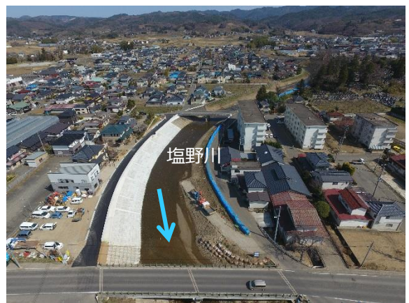
塩野川（伊達市梁川町） 堤防・護岸整備状況
