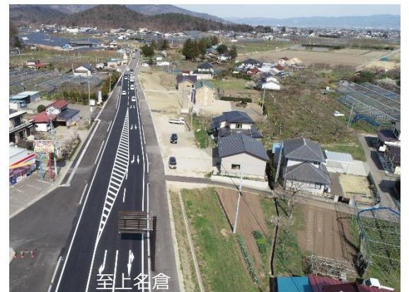
上名倉飯坂伊達線（福島市大笹生）福島大笹生2工区
