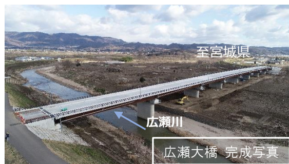
国道349号 梁川バイパス (伊達市梁川町)
