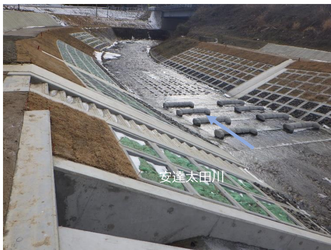
安達太田川（二本松市太田）開削護岸
