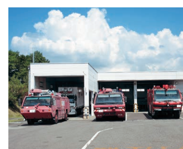
消防車庫 航空機に事故・火災が発生したとき、これを消火する車輛を格納しておく建物で、大型化学消防車(12,500ℓ台)(10,500ℓ台)(6,100ℓ台)と給水車(8,000ℓ台)、医療用搬送車(1台)を配備しています。
