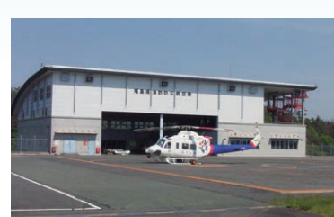
消防防災航空センター 福島県消防防災ヘリコプターの基地です。
