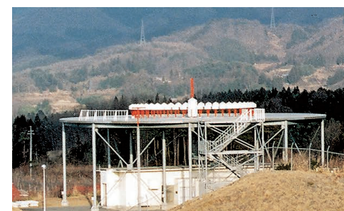
VOR/DME 飛行中の航空機に方向と距離を知らせる施設です。
