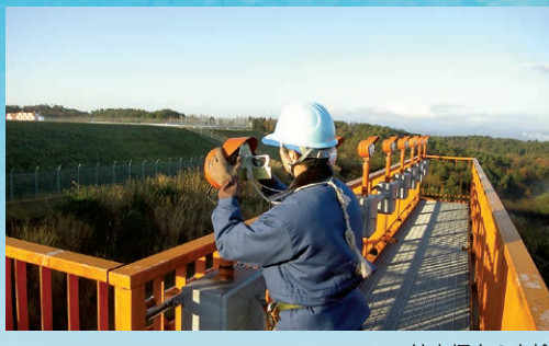
航空灯火の点検
