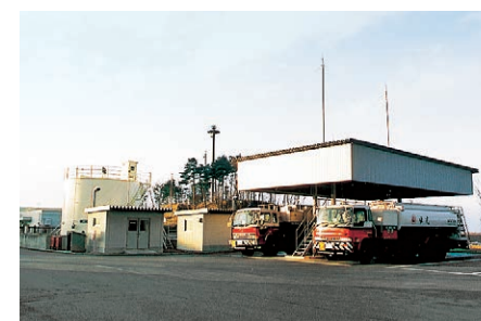
給油施設(POL) 航空機に給油するジェット燃料を扱っており、200kℓタンク1基を有しています。
