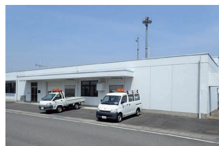
電源局舎 航空機に給電するための電源設備を収容する建物で、停電時に給電可能な発動発電機等も装備しています。
