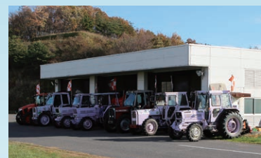
資器材倉庫 車列機械などの倉庫です。
