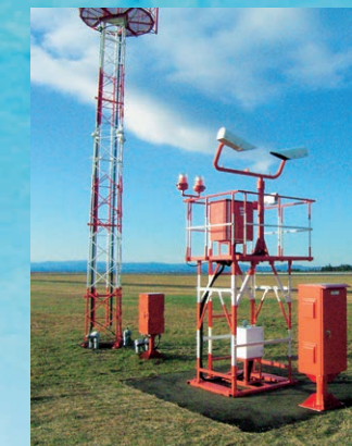
VOR/DME 飛行中の航空機に方向と距離を知らせる施設です。
