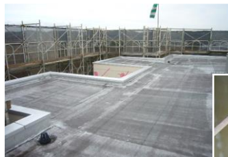
【施工状況（屋上防水改修）】
