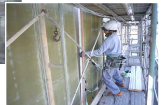
【施工状況（外断熱）】
