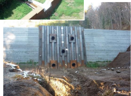
【2号えん堤（施工状況）】
