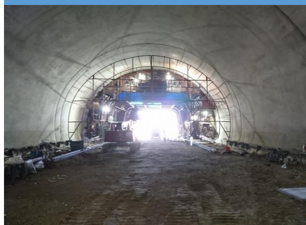
国道294号 南湖トンネル
