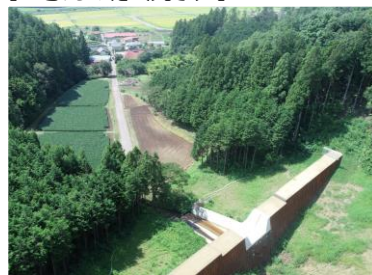
【1号えん堤（完了）】
