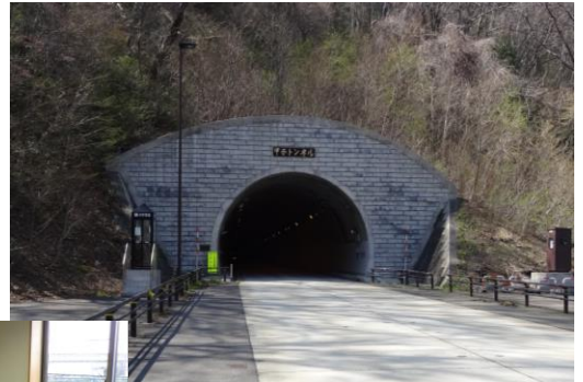
甲子トンネル西郷側坑口
