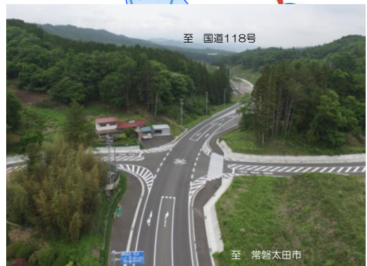
④矢祭町（国道349号）下関バイパス整備
