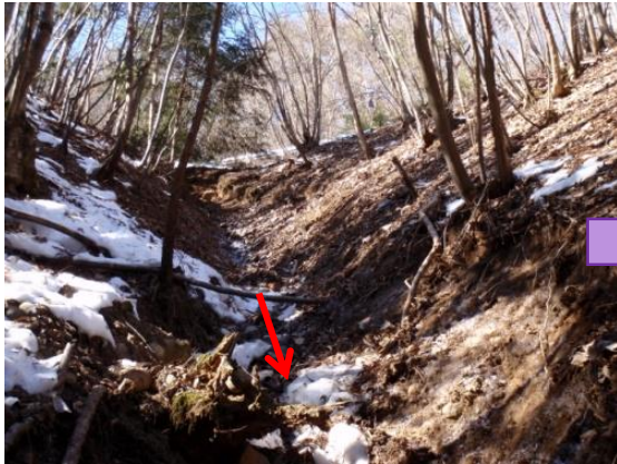
【溪岸浸食状況】
