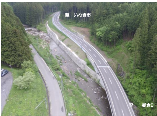
③鮫川村（国道289号）渡瀬バイパス整備
