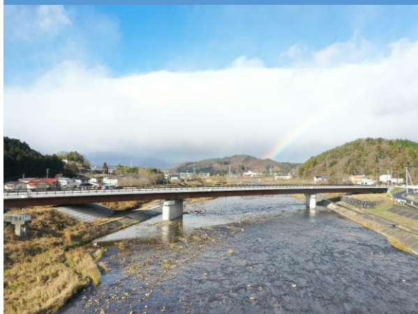
国道294号 小峰大橋
