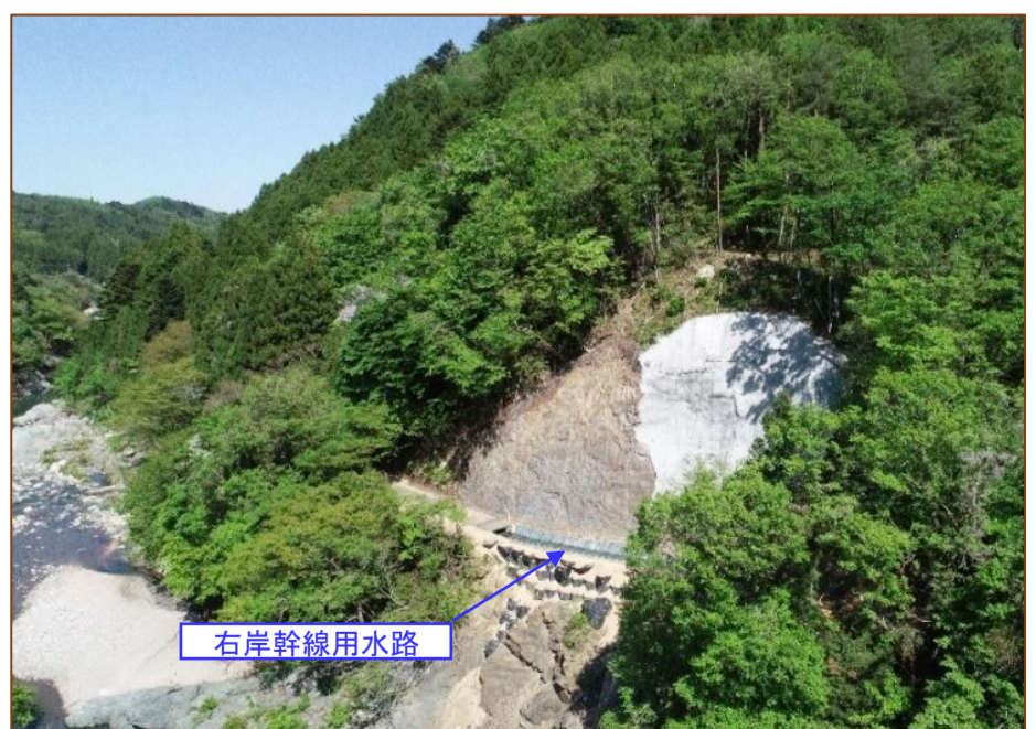
【復旧状況 R3.5.7】 (コンクリート水路の本復旧に向け 法面保護工を実施中)
