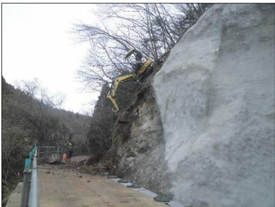
【復旧状況 本復旧工事開始 R3.1~】 (無人掘削機による急斜面の追加掘削)
