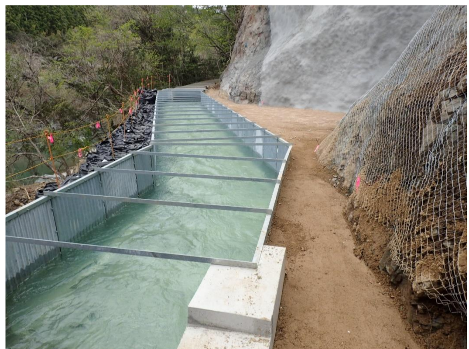
【復旧状況 応急工事完了 R2.4】 (通水開始)
