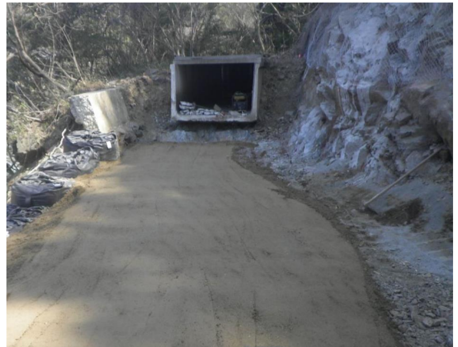
【復旧状況 崩落した土砂を撤去】
