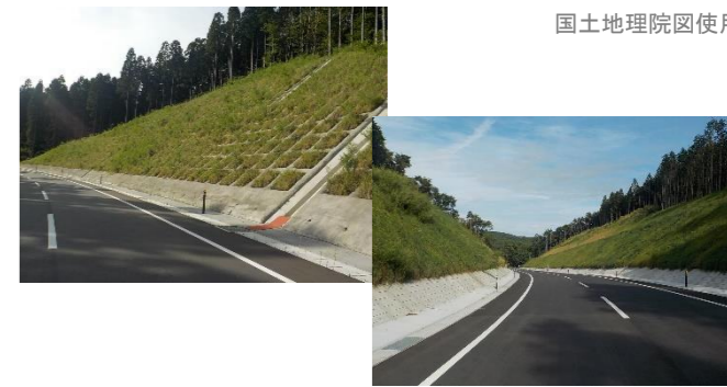
④青生野工区整備完了状況
