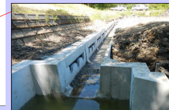
環境配慮水路布設状況
