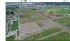
R2年度施工区域 A=4.7ha (R2～R3債務工事)
