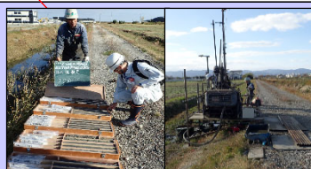
ボーリング調査状況
