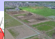
R3年度施工区域
