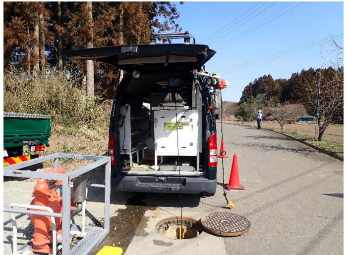
施設管理用のマンホールから調査を実施
