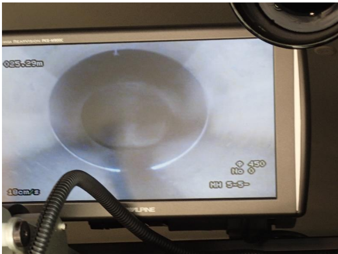
管内部の様子
