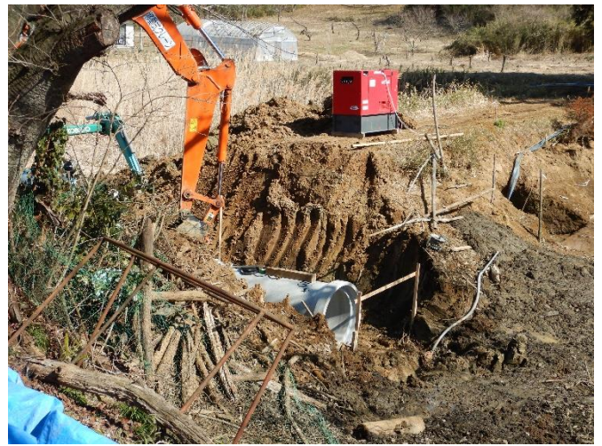
堤体を掘削した様子
