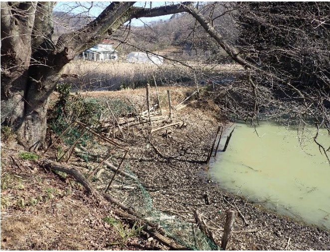
工事前の中ノ内ため池
