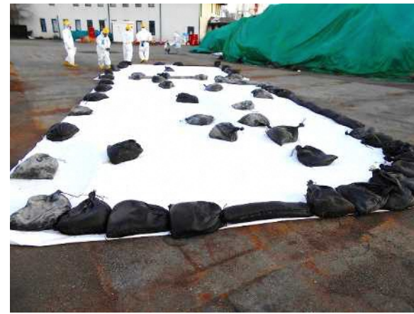
写真2.除去跡への養生(3月24日)
