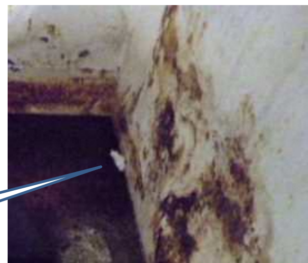
写真2.コンテナ内面・補修箇所の状況
