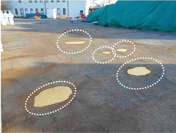
写真1.堆積物除去・除染材塗布(3月24日)
