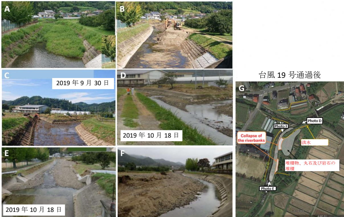
図 3.11 上小国川での掘削工事（2019 年 9 月）と台風 19 号（2019 年 10 月 12 日～13 日）の前後の写真。
