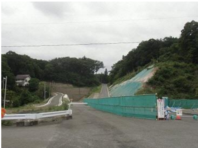
栄町道路改良工事
