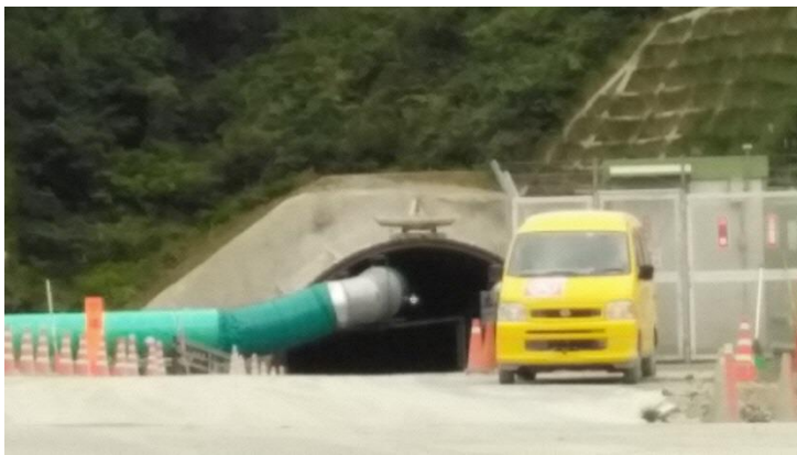
博士トンネル昭和村側入口（昭和村）
