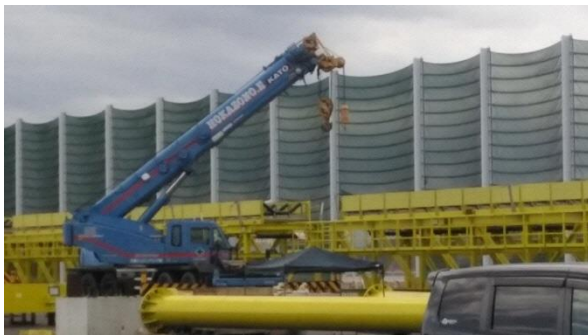
防塵柵と建造中の機械
