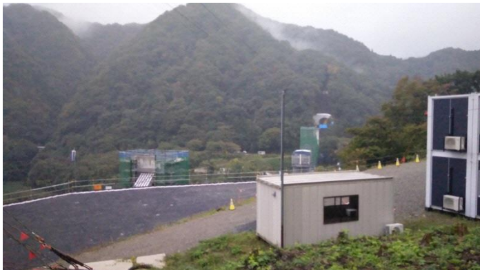
小沼崎B P橋台工事
