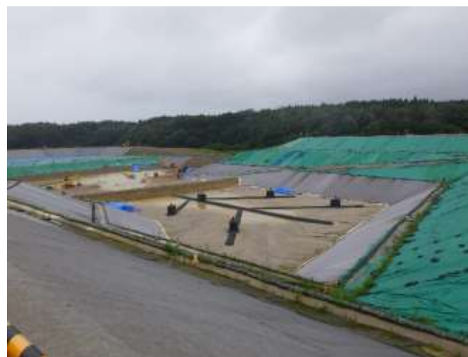
土壌貯蔵施設の集排水管整備状況の確認
