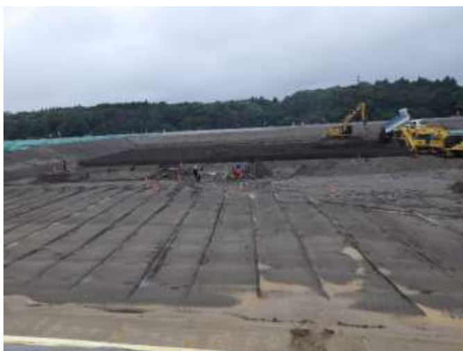
土壌貯蔵施設の埋立状況の確認
