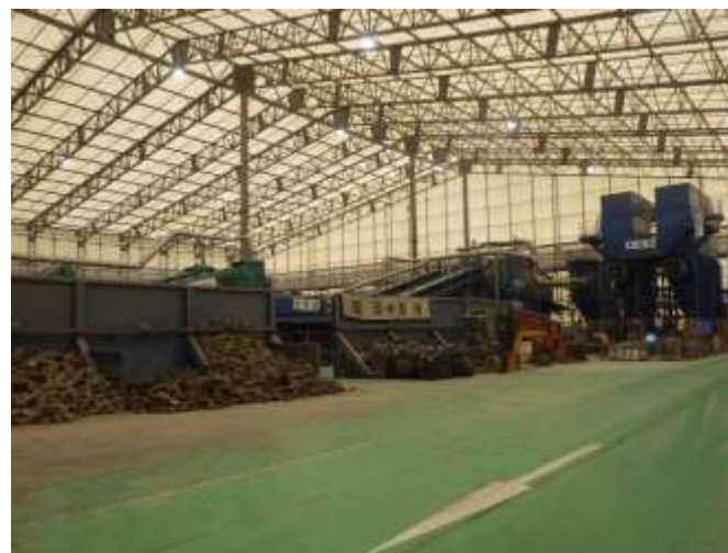
受入・分別施設の分別処理状況の確認
