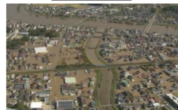
⑩阿武隈川における浸水被害状況 (福島県本宮市)
