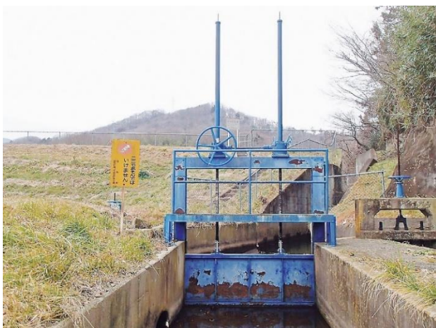
塗装が剥離している水門を補修（伊達市）
