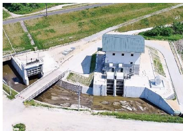
五十沢排水機場（伊達市）
