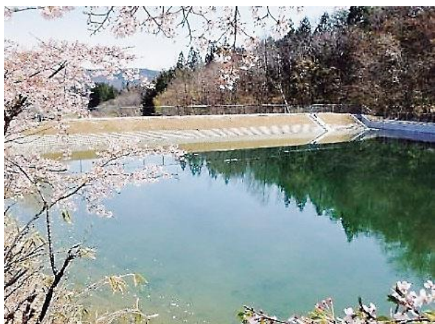
ため池等整備事業（ため池整備） 小今泉地区（田村市）
