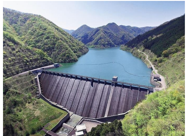
新宮川ダム（会津美里町）
