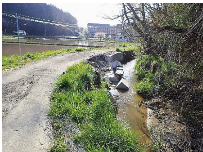
水路法面の崩落 (田村市)
