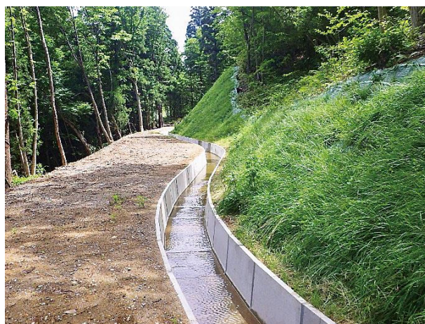
ため池等整備事業（用排水施設整備） うつろ第4分水路（会津美里町）
