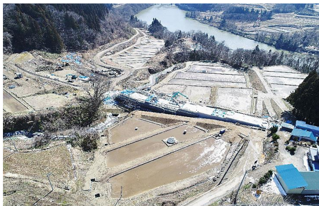
あがつ 地すべり対策事業 揚津地区（喜多方市） ※中央は県道復旧（県土木部所管）
