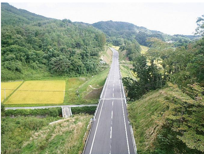
広域農道整備事業 田村3期地区（田村市）
