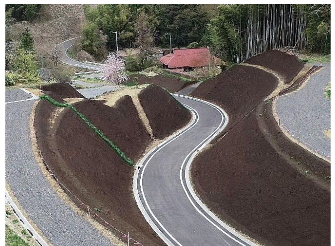
基幹農道整備事業 中石井3期地区（矢祭町）
