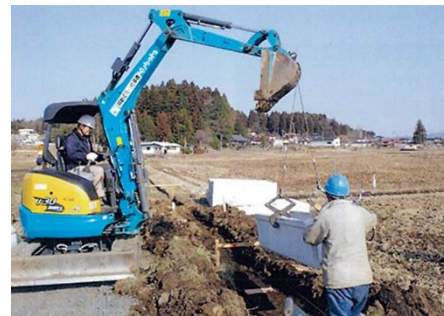
直営施工による水路整備
