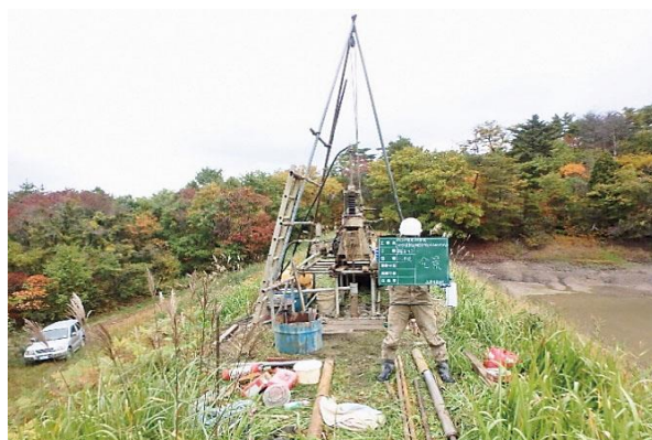
堤体のボーリング調査
