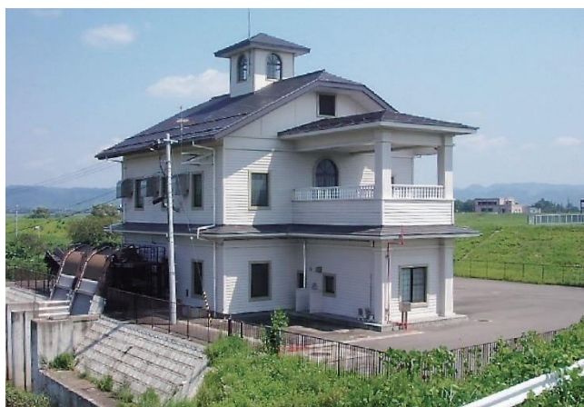
伊達崎排水機場（桑折町）
