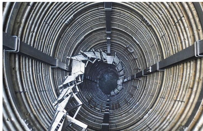
しゅうすいせい 「集水井」内部 揚津地区（喜多方市）
