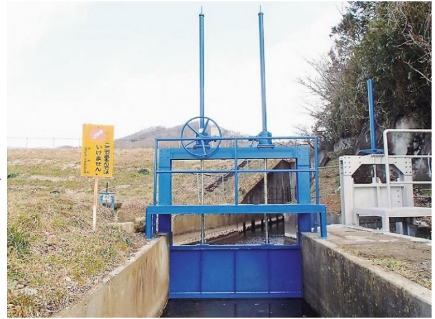
塗装が剥離している水門を補修（伊達市）
