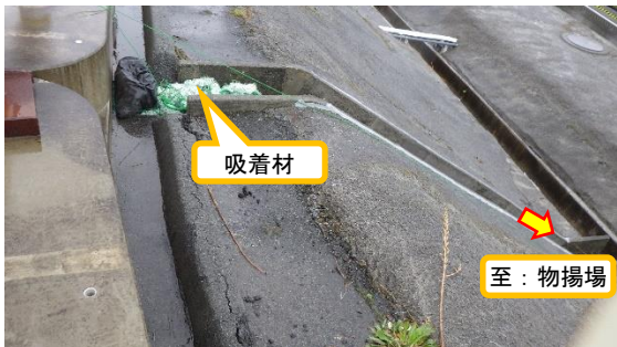
(写真1-2) 排水溝に設置された放射性物質を 吸着する吸着材
