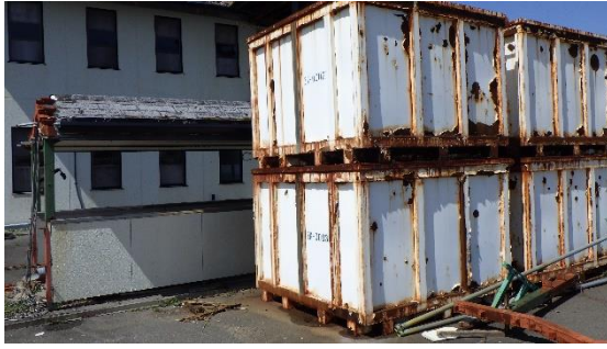
(写真2-1) 当該エリア付近に保管されている コンテナ4基周囲の状況 (令和3年3月29日撮影)
