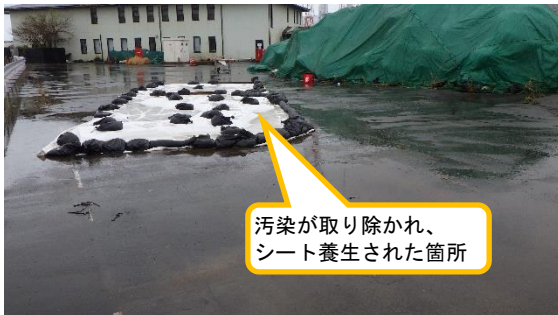
(写真1-1) 瓦礫等一時保管エリアW2 (北東側から撮影)
