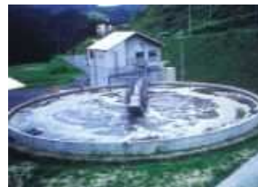
畜産環境対策施設
