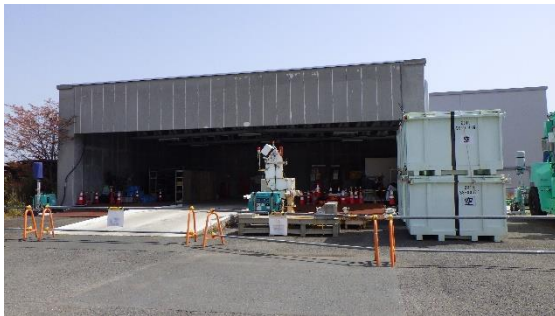
(写真1-2) 固体廃棄物貯蔵庫第2棟入口 （西側から撮影）
