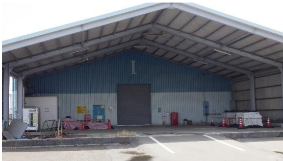
(写真1-3) 固体廃棄物貯蔵庫第1棟入口 （西側から撮影）
