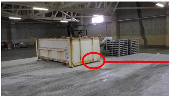
(写真 4 - 1) パテで補修したコンテナの状況
