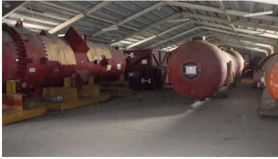
(写真6) 固体廃棄物貯蔵庫第1棟の状況
