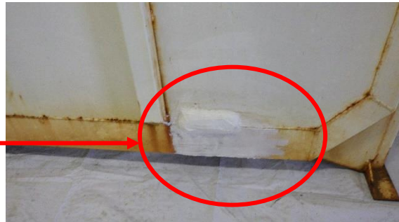
(写真 4 - 2) パテ補修箇所の状況
