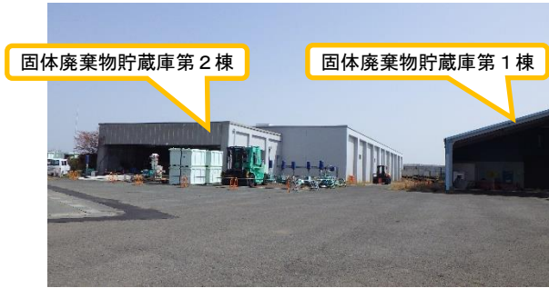
(写真1-1) 固体廃棄物貯蔵庫第1棟、第2棟の 外観（南西側から撮影）
