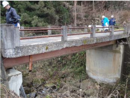
施工から44年が経過した信田橋
