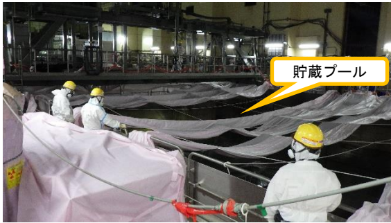
(写真1-2) サイトバンカ建屋2階貯蔵プールの 状況
