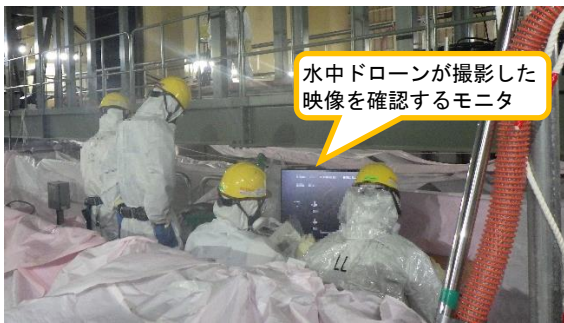
(写真2-1) 貯蔵プールの調査状況
