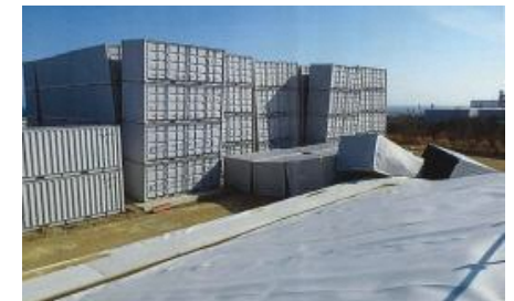
瓦礫保管エリア一時保管施設での コンテナ傾き及び転倒
