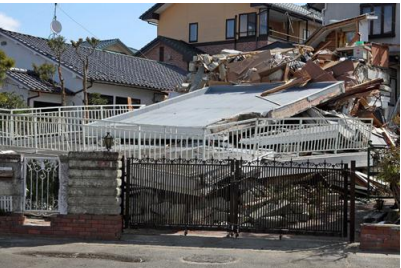
家屋の被災状況（南町地内）
