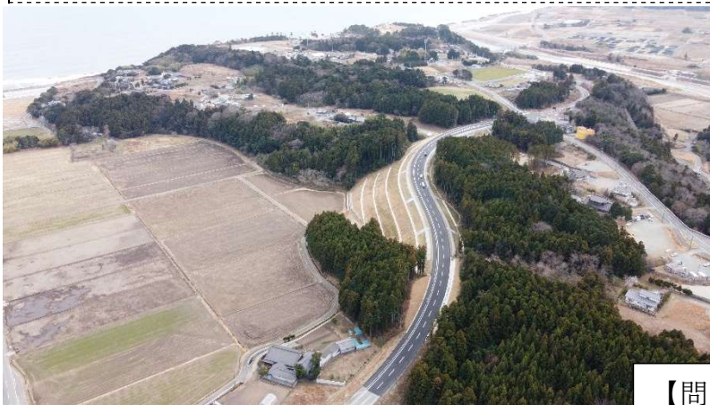
← 井出工区 一部供用開始区間
